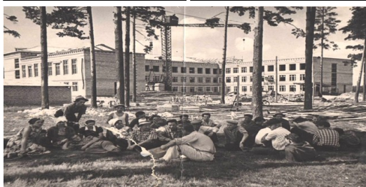
2 Строительство будущей школы
